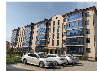
Жилой комплекс примера-Kazakhstan
